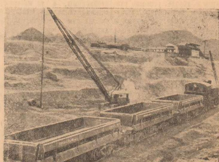
■ Азербайджанская ССР. Широко развернулось строительство Мингечеаурской гидроэлектростанции. Десятки больших экскаваторов и поездов думпкаров работают круглые сутки. Основные работы проводятся в котловане, где идет укладка бетонных донных труб, по которым будет пущена река Кура. Все работы механизированы.
