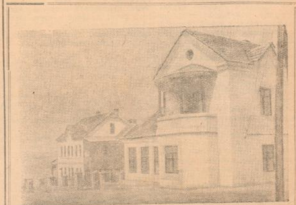
В городе Николаеве широко развернулось строительство и восстановление жилых домов. Наряду с постройкой многоэтажных корпусов возводятся и небольшие дома. На снимке: дома, построенные у берега р. Южный Буг. Фото И. Будника. Пресскляше ТАСС
