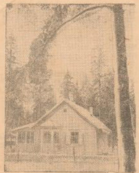
По проекту, разработанному Академией архитектуры СССР в Подмоскovie смонтирован опы- тный индивидуальный дом нового типа из деталей заводского изго- товления. В доме — три комнаты, ванная, кухня, терраса. Отопление цен- тральное. В течение круглых су- ток подается горячая вода. При серийном производстве дома этого типа будут монтироваться за 5—6 дней. На снимке: общий вид дома. Фото В. Егорова.
