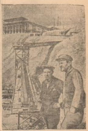
Азербайджанская ССР. На строительстве Мингечаурской ГЭС начата укладка бетонных труб для отвода русла реки Куры. Бетон к месту работы подается по транспортеру. На снимке: общий вид строительных работ. На переднем плане начальник экскаваторных работ инженер Ч. К. Кусов (справа) и заместитель начальника участка строительства А. Б. Асланов. Фото Ф. Шевцова.
