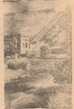
Армянская ССР. Успешно идут работы по сооружению каскадных гидроэлектростанций Севано. Некоторые из них уже пущены в ход. На снимке: Канакирский ГЭС. Фото Б. Неблянского.
