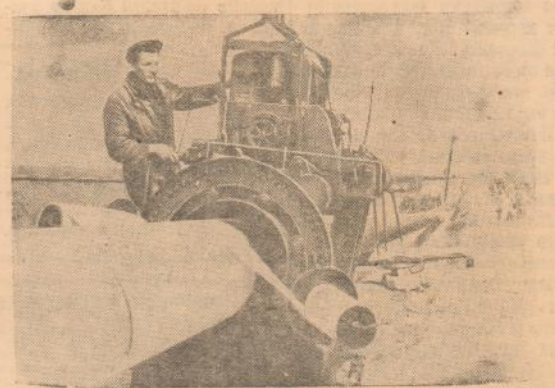
Ленинградская область. На строительстве газопровода Кохля-Ярва-Ленинград.
