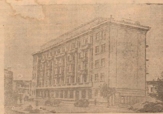
Сталинград. Закончилось восстановление 5-этажного жилого дома по Коммунистической улице. В этом доме 33 квартиры. В каждой квартире по две-три комнаты, кухня, ванная, водопровод, канализация, электрический свет. В первом этаже будет большой магазин с промтоварами, бакалейно-гастрономическим, мясорыбными отделами. Фото А. Маклецова. Прессканше ТАСС.
