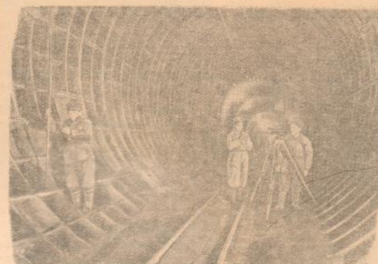
На строительстве четвертой очереди московского метрополитена имени Л. М. Кагановича девятимесячный план перевыполнен. Коллектив строителей области выполняет годовую программу к 7 ноября. На снимке: готовый участок тоннеля на перегоне от станции «Курская» к станции «Тагаская». Фото Л. Вельжанина. Пресскляше ТАСС.
