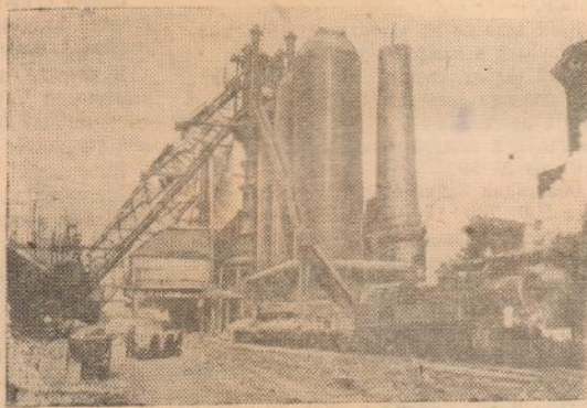
Воронилоск. Началось восстановление одной из крупнейших доменных печей юга — домна № 2 металлургического завода имени Воронилоска.
