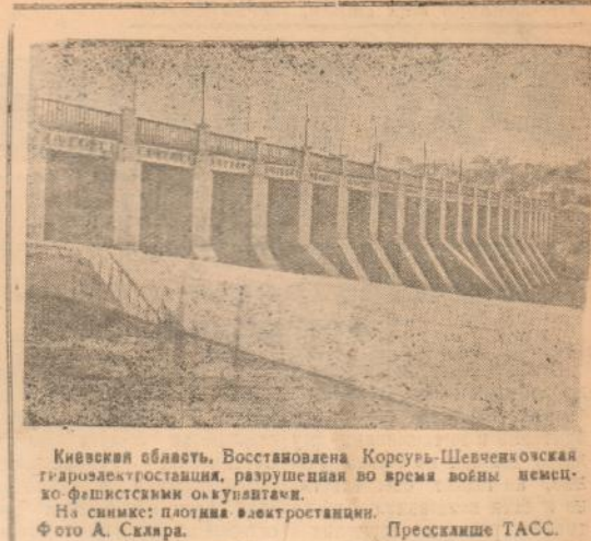
Киевская область. Восстановлена Корусь-Шевченковская гидроэлектростанция, разрушенная во время войны немецко-фашистскими оккупантами. На снимке: плотина электростанции. Фото А. Селяра. Пресскляше ТАСС.
