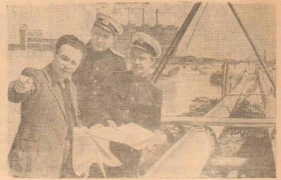
Киев. Широко развернулись работы по газификации столицы советской Украины. Идет подготовка к прокладке газопровода через Днепровский залив к Киевской районной электростанции. На снимке: главный инженер треста «Киевгазстрой» Я. Г. Гусинский (слева), начальник строительства участка Эпрона Е. А. Дегтярев (справа) и его помощник И. Н. Симонов на трассе газопровода.
