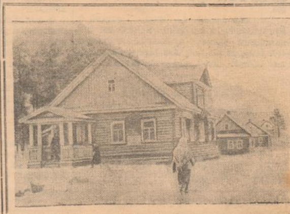
Псковская область. Поселок Ляды был полностью сожжен немцами. Сейчас на месте пепелищ раскинулся новый поселок—центр Лядского района. Здесь уже построено много жилых домов, клуб, общественная столовая, районный партакбюлет, заканчивается строительство больницы.
