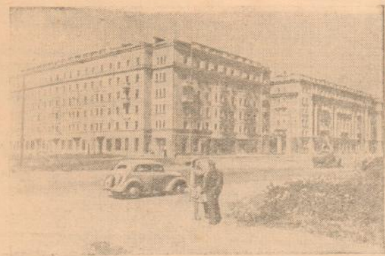
Ленинград. На Московском шоссе широким фронтом ведутся работы по строительству жилых домов. Закончена стройка и архитектурная отделка нескольких корпусов, строительство которых было прервано в дни Отечественной войны. Находясь в непосредственной близости от линии фронта, район Московского шоссе был сильно разрушен. Теперь это один из наиболее благоустроенных районов города.
