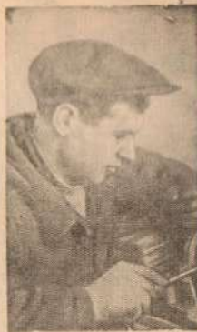
Слесари-электрики Ижевского речного порта М. П. Глуценко за ремонтом масляных двигателей для механических португальской. Ижевск. Фото В. Арского.
