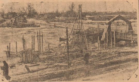
Подготовка к наводнению. Для защиты нового плашкоутного моста на реке Клязьме строятся ледорезы для защиты от ледохода
